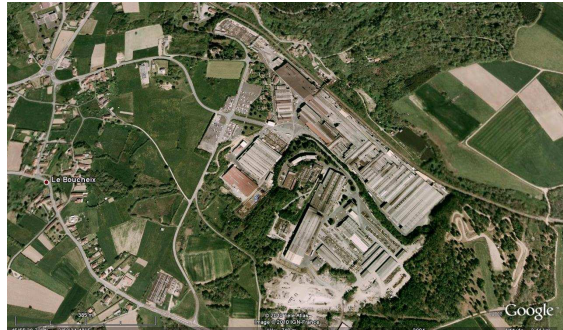
Vue aérienne de l'aciérie Aubert et Duval
